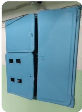
Электрощит должен быть отремонтирован, вставлены стекла, установлены замки, нанесена нумерация квартир
