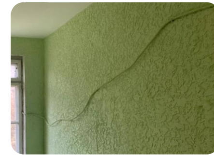
Слаботочные сети должны быть приведены в надлежащее состояние. Убраны в ПВХ-трубы/кабель-лотки.
