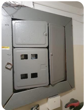
Электрощит должен быть отремонтирован, вставлены стекла, установлены замки, нанесена нумерация квартир
