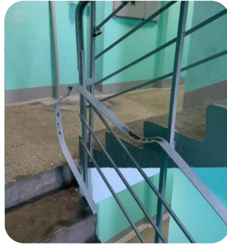
Перила должны быть отремонтированы, восстановлены балясины,
